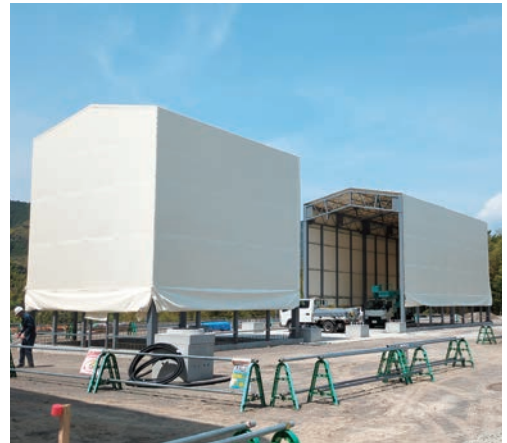
グリーンアローズ中部の静岡新工場建設の様子
