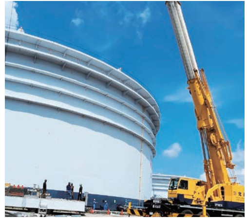
システム機工の大型タンク清掃作業の様子
