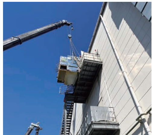
杉本商事の工場内設備撤去工事
