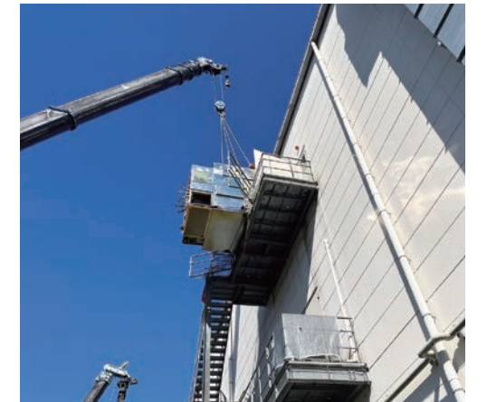
杉本商事の工場内設備撤去工事
