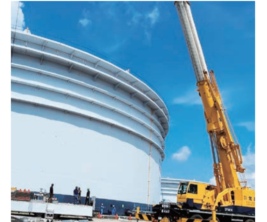
システム機工の大型タンク清掃作業の様子
