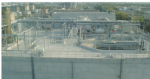
廃液の生物処理を行う活性汚泥処理施設(ダイセキ名古屋事業所)
