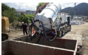
側溝に堆積した土砂の回収 (広島県坂町)
