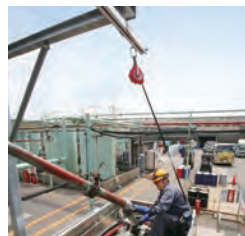
第一工場のローリー充填所に、安全帯設置用のレールを設置
