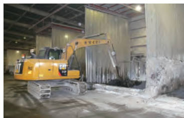
防じんカーテンを設置
