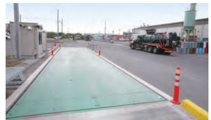
渋滞緩和を図るため、第二工場に新たに計量器を設置
