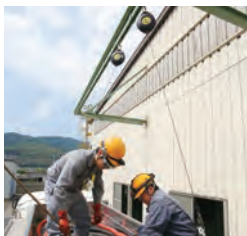
サンプリング時の転落防止対策として安全帯設置用のレールを設置
