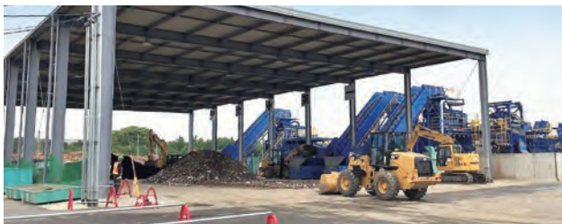
二次仮置場における混合廃棄物処理
