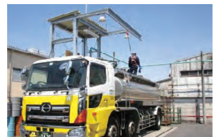
第二工場転落防止
