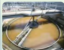
活性汚泥処理
