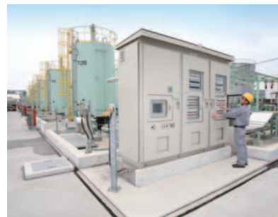
各タンクには温度センサーを設置しており、設定 温度以上になると警報を発生して自動で散水・冷却。 安全管理も徹底している
