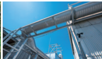
近隣への悪臭を防止する活性炭吸着方式の脱臭装置
