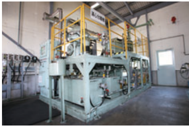
再生重油設備を増設
