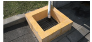
屋根雨水に汚水が混入しないよう囲いを設置(関西事業所)
