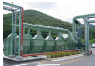
スクラバー+活性炭吸着方式による 脱臭装置(関東事業所)
