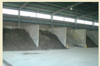
汚泥リサイクル処理施設
