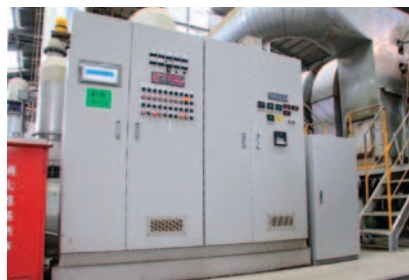
乾燥機排煙ファン・インバータ取付(北陸事業所)
