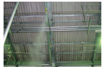
静電対策 ミスト噴霧装置(千葉事業所)
