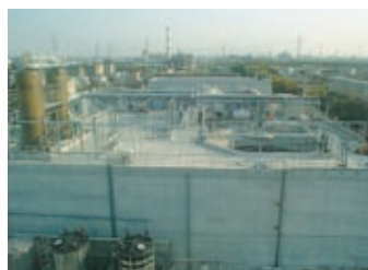
名古屋廃水処理施設
